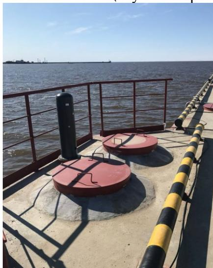
Рис. 3. Пожарный колодец на причале
