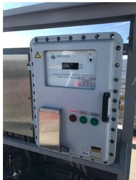
*Рис.5 Щит станции катодной защиты*
